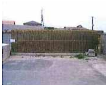
ガラ(廃材)置場に高さ制限 の表示
