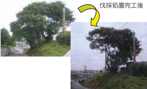
公共道路・公共電気配線への影響を配慮し、 構内植樹樹木の伐採処置実施
